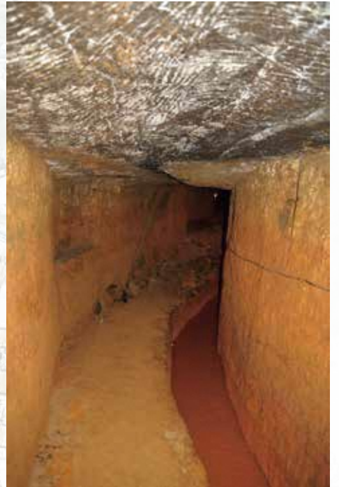
南沢疎水道 (17世紀末に開坑された排水坑道) 6か所から同時に掘り進める「迎え掘り」工法を採用し、誤差なく貫通させています。壁面や天井は丁寧仕上げられており、当時の掘削技術の高さを物語っています。
