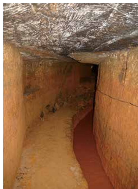
高度な掘削・測量技術を示す南沢疎水道 （専門的な技術をもつ労働者の 精微な手工業による排水坑道）
