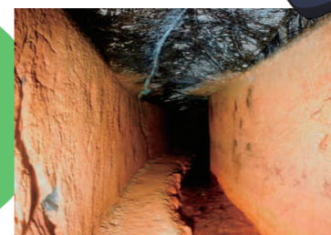
みなみさわすいどう 南沢疎水道
