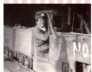
2 トロッコで運ぶ (2. Transport with trolley) 運ばんも人からトロッコに。一度にたくさんの鉱石を運べるようになりました。
