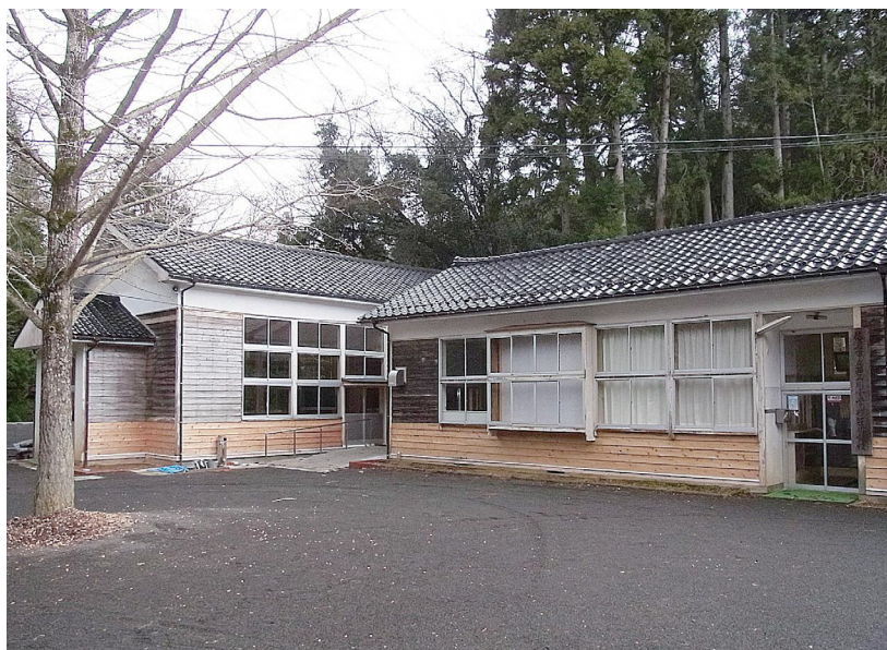
改修工事後の旧西三川小学校笹川分校
