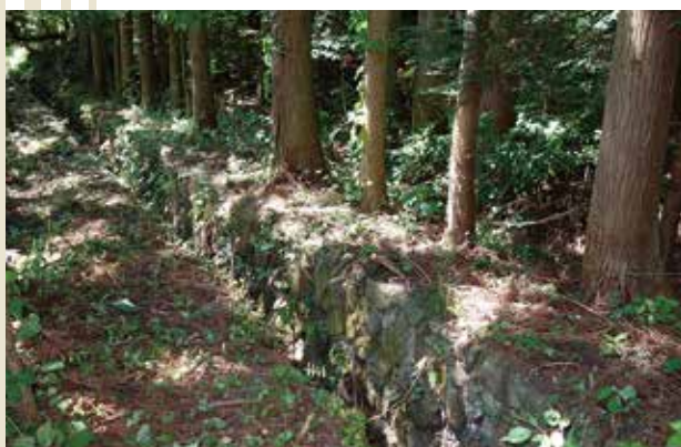
取水口付近の石積導水路
