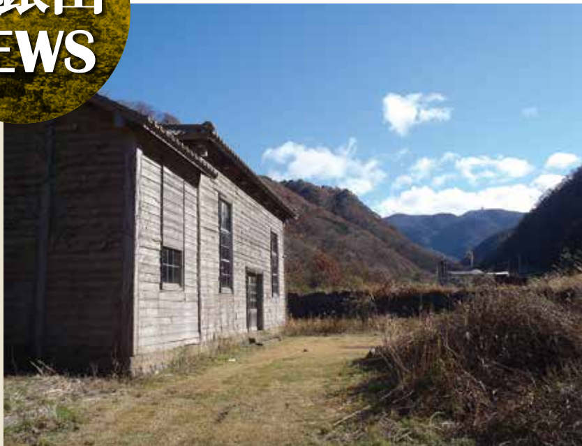
戸地川第二発電所建物と河川水源となる山々
