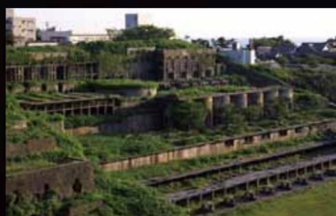
北沢浮遊選鉱場 Kitazawa flotation plant(国指定史跡) シツクナーと同時期に、隣接して建設された。最大で月間7万トンの鉱石を処理し、当時「東洋一」と言われた。
