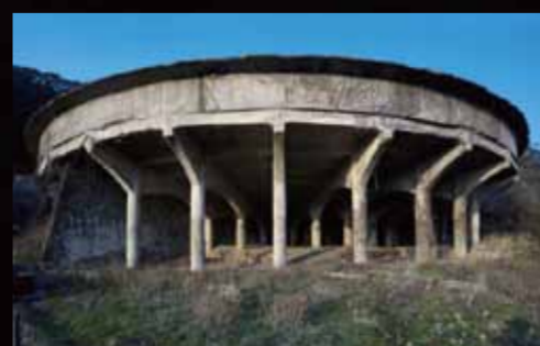
50メートルシツクナー 50meter thickener(国指定史跡) 直径50mの鉄筋コンクリート製で昭和13(1938)年頃からの金の増産体制時に建設された。泥状の鉱物を鉱物と水に分離する施設。
