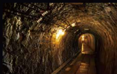
道遣坑 Doyu mining tunnel (国指定史跡・国重要文化財) 明治32(1899)年、「道遣脈」の開発を目的に開削された主要運搬坑道。今でもトロッコのレールが残っている。
