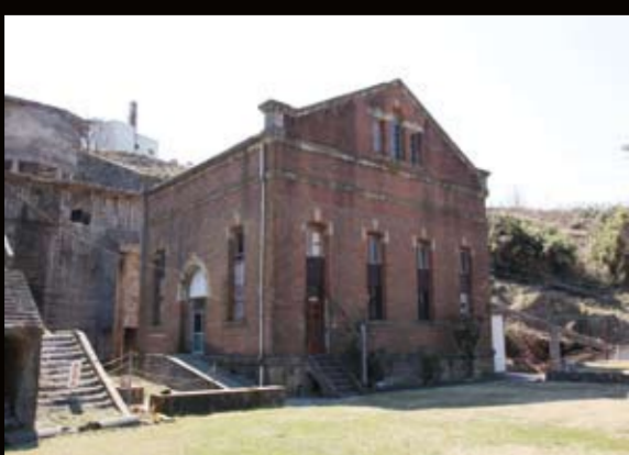
北沢火力発電所跡（佐渡金山近代写真展示館） 明治41(1908)年に完成した石炭火力発電所。500kWのsteamタービン1基が設置され製鉱場が蒸気機関から電動機に代わった。昭和初期の大増産時には1800kWに増強された。
