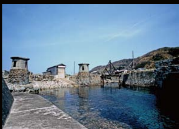
大間港 鉱石や石炭などを搬出するために築港され、明治25(1892)年に完成した。石灰のたき工法護岸と1.2tクレーンの台座やレンガ倉庫が現存。
