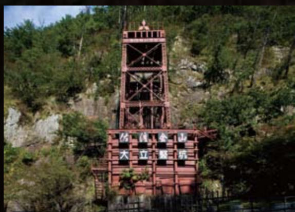
大立堅坑（登録有形文化財） 明治10(1877)年にドイツ人技師の指導により完成した日本初の西洋式堅坑。この鉄製のやくらは、昭和13(1938)年頃からの金の増産体制時に建設された。
