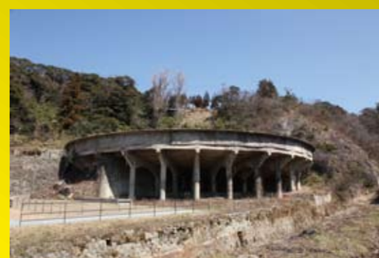
シクナー 直径50mの鉄筋コンクリート製で昭和13(1938)年頃からの金の増産体制時に建設された。泥状の鉱物を鉱物と水に分離する施設。
