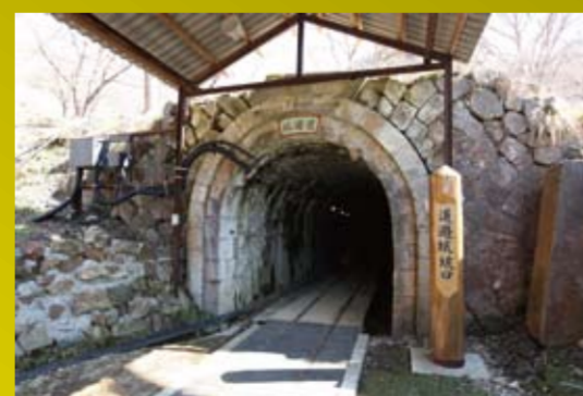
道遊坑坑口 明治32(1899)年、「道遊脈」の開発を目的に開削された主要運搬坑道。今でもトロッコのレールが残っている。
