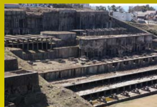
北沢浮遊選鉱場 シクナーと同時に、隣接して建設された。最大で月間7万トンの鉱石を処理し、当時「東洋一」と言われた。
