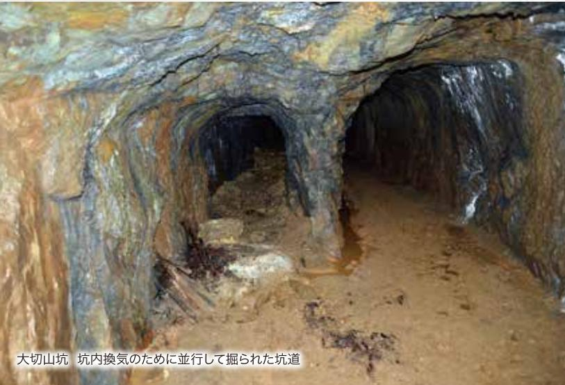
大切山坑 坑内換気のために並行して掘られた坑道
