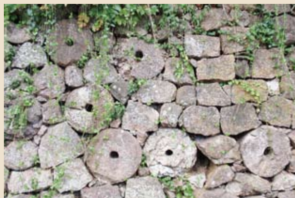
石垣に転用された石磨
