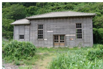
⑨ 戶地川第二發電站
