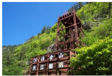
④ 相川金銀山(大立豎坑)
