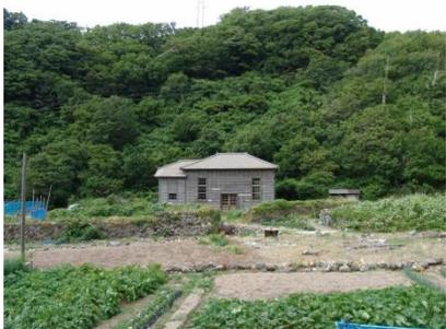
当該地は相川市街地より北へ約9km離れた戸地地区にある、第二発電所施設及び導水路跡を含む範囲です。戸地川第二発電所は、1919年、戸地川河口付近に建設された、出力510kVaの水力発電所で、1977年まで稼働し、鉍山の電力をまかさないました。1910年代、増大しつつあった佐渡鉍山の電力需要を満たす施設として設置されました。当時の発電所建屋、発電設備、水路、排水口が良好に残っています。
