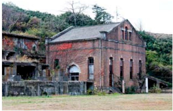
北沢地区（火力発電所） d-28
