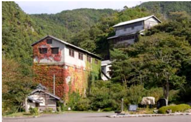
間ノ山地区（貯鉱舎） d-27
